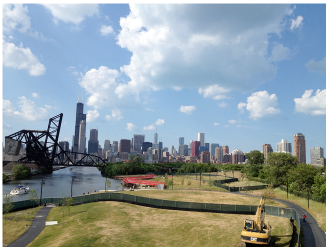
シカゴ市の景色。 工事中の公園。
